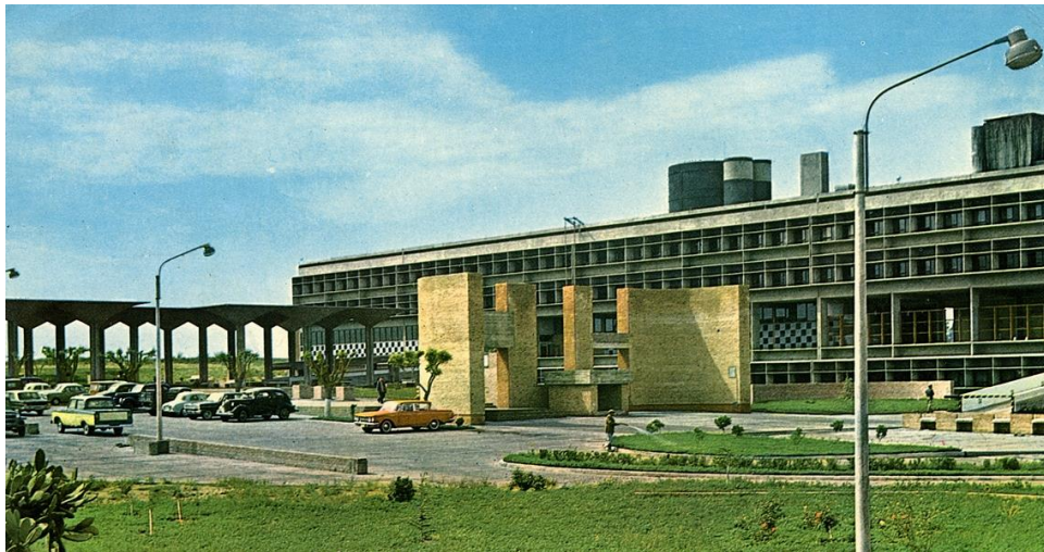
Casa de Gobierno, espacio de ingreso y semicubierdo de "sombillas". Fotografía Museo de la Cámara de Diputados de la Provincia de La Pampa
